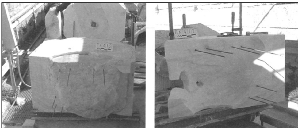
Εικόνα 8. Χρήση ράβδων τιτανίου για τη συγκόλληση θραυσμένου σπονδύλου (από τις εν εξελίξει εργασίες αναστήλωσης στον Παρθενώνα). Διακρίνεται καθαρά το αυθεντικό υλικό και το συμπλήρωμα από νέο υλικό.
